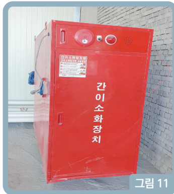
[그림 11] 전원 미연결 간이소화장치 [그림 12] 간이소화장치 물 방사 장면
