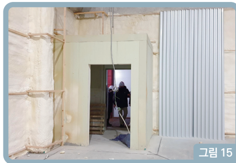
[그림 15] 계단 출입구 간이피난유도선 미설치
